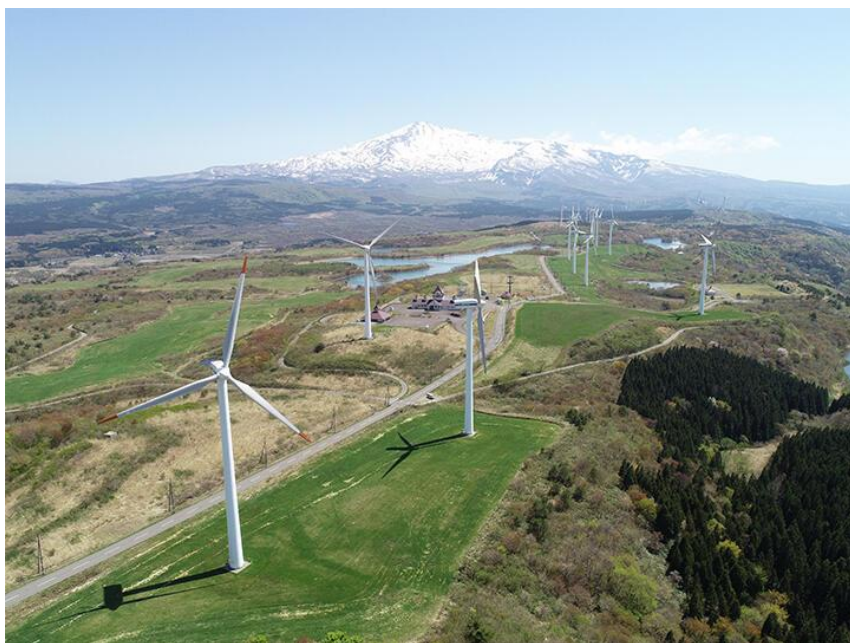
現仁賀保高原風力発電所現況写真（JパワーHPより）
