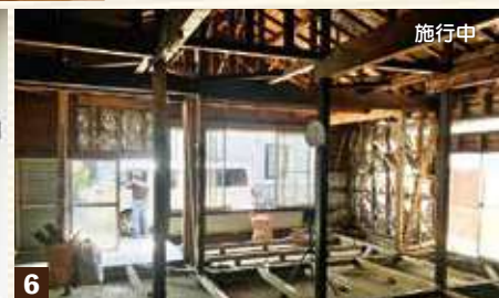
6 通気と白アリ対策のため床の高さを上げ、壁には新築同様の断熱材を設置。天井にも十分な断熱材を入れ、冷暖房機器に頼らない、省エネで快適な住まいの工夫をしています
