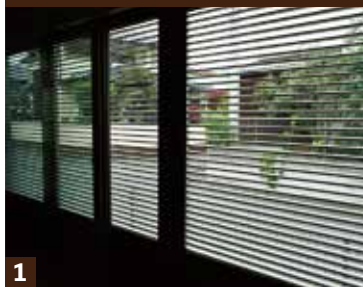
1 プラインドのように角度を調整できる雨戸で、防犯と風通しを両立
