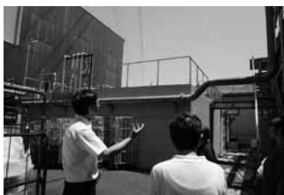
製造工程で出た排水の濾過設備も確認しました
