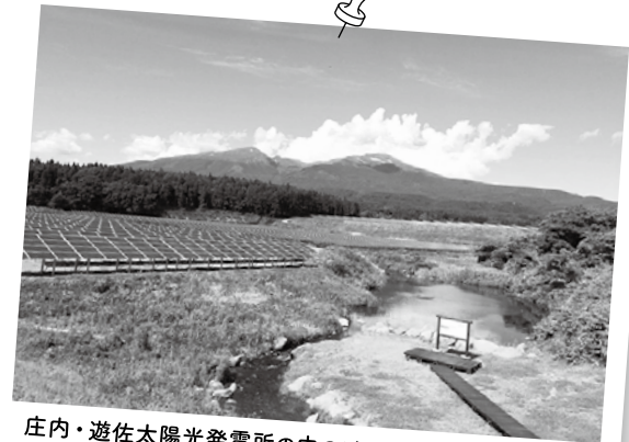
庄内・遊佐太陽光発電所の中のビオトープ。建設時から地域の環境を壊さない配慮をして設置しています。
